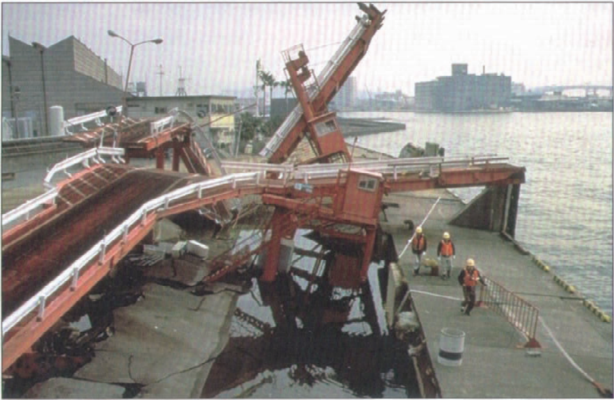
图 20 1999 年特大阪神或称神户地震由于地基失效引起的神户渡轮码头倒塌。 —加州大学伯克利分校国家地震工程信息服务与太平洋地震工程研究中心
