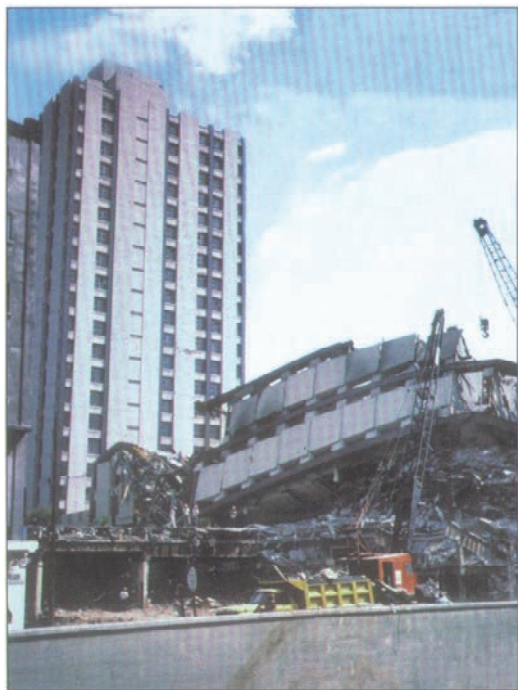
图 18 1985 年墨西哥城地震致皮诺苏亚雷斯 办公区一栋 21 层建筑垮塌。 —Robert Reitherman
