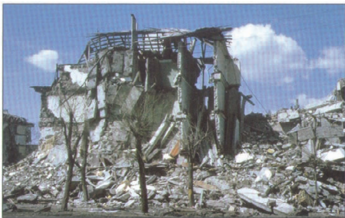
图 19 1988 年亚美尼亚地震中在列宁纳坎倒塌的 3 层预制混凝土结构,右侧为倒塌的 9 层结构。
