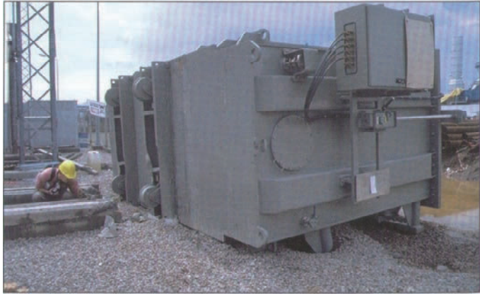
图 21 铁轨上的变压器顺时针侧翻，1999 伊兹米特或称科贾埃利地震。 —加州大学伯克利分校国家地震工程信息服务与太平洋地震工程研究中心
