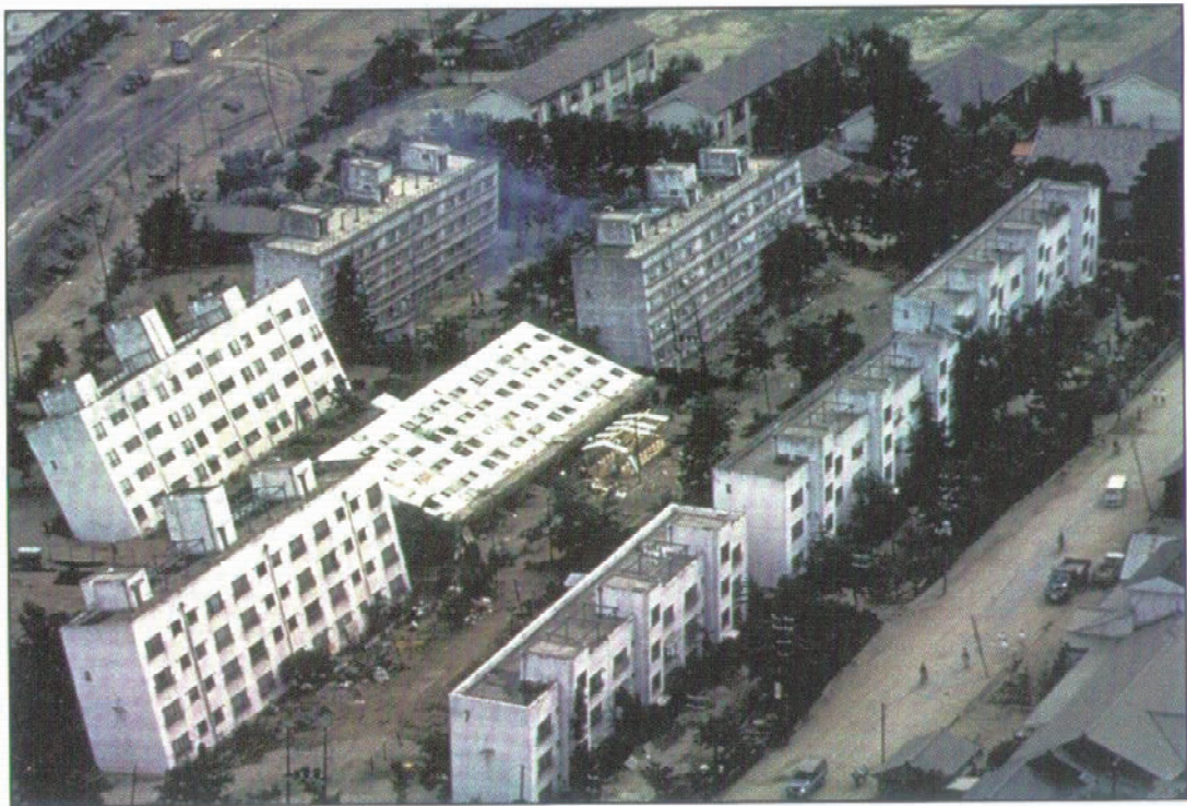
图 11 1964 年新潟地震中液化引起的土的承载强度的损失。
