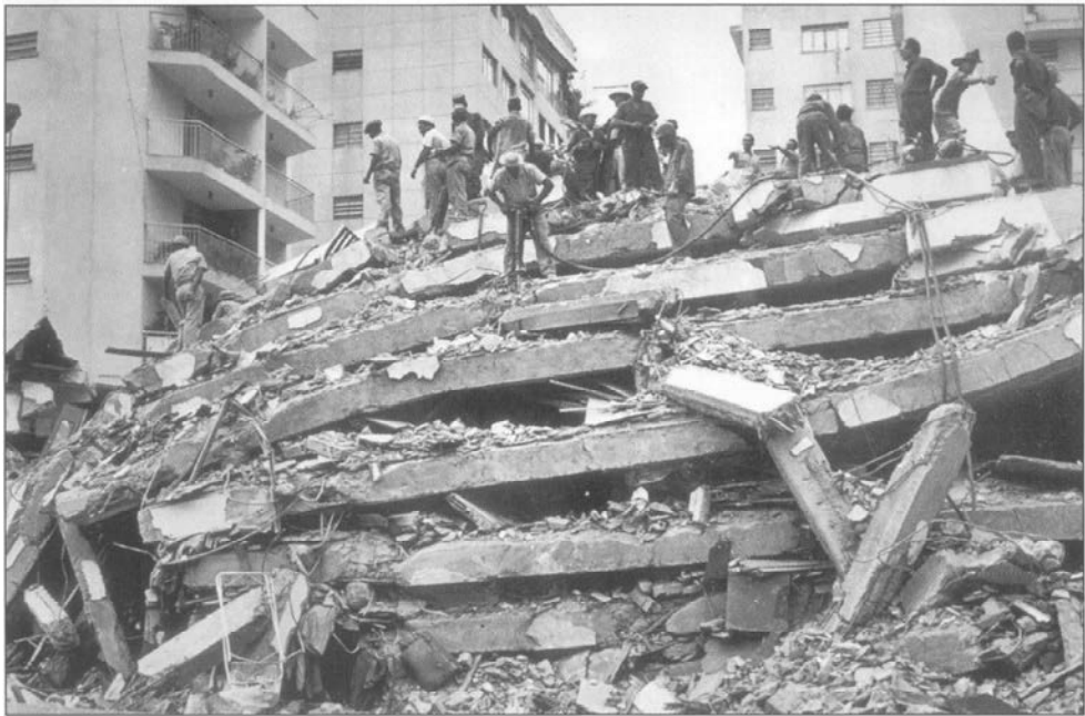
图 12 一栋 11 层建筑完全倒塌，1967 年加拉加斯地震。 —加州大学伯克利分校国家地震工程信息服务与太平洋地震工程研究中心
