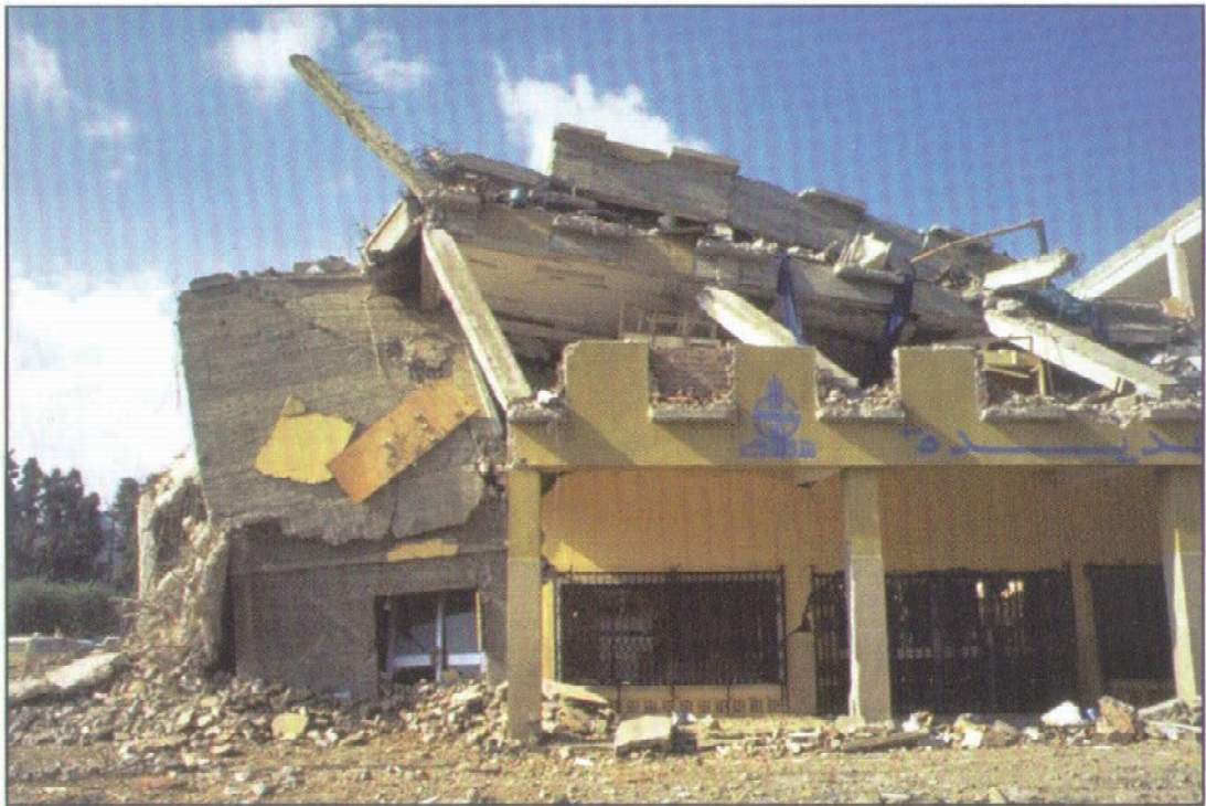
图 17 四层建筑完全坍塌，阿尔及利亚 1980 年阿斯南地震。 —加州大学伯克利分校国家地震工程信息服务与太平洋地震工程研究中心
